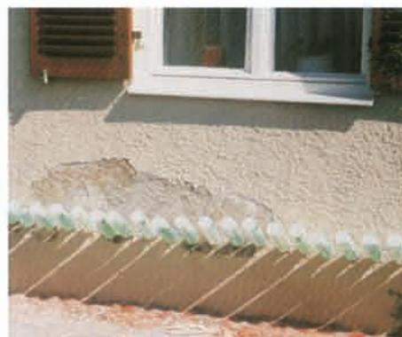
Daraufhin werden die Kartuschen in die Bohrlöcher gesteckt.
