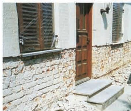
Hat sich der Wirkstoff im Mauerwerk verteilt, wird der alte Putz abgeschlagen.
