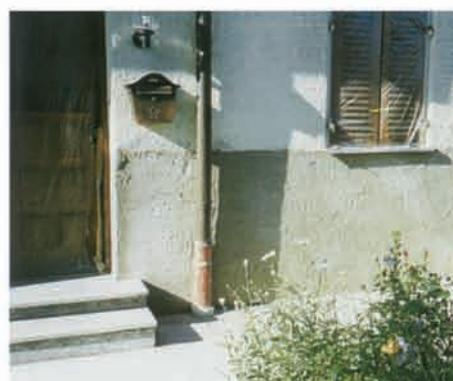
Nun wird dehnfähiger Kalkzement- oder reiner Zementmörtel aufgebracht.
